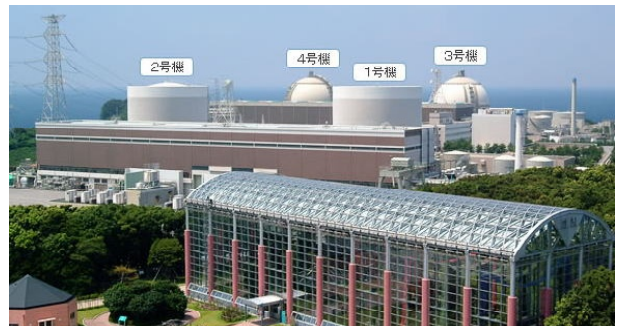
長崎から 80 キロにある 玄海原子力発電所
